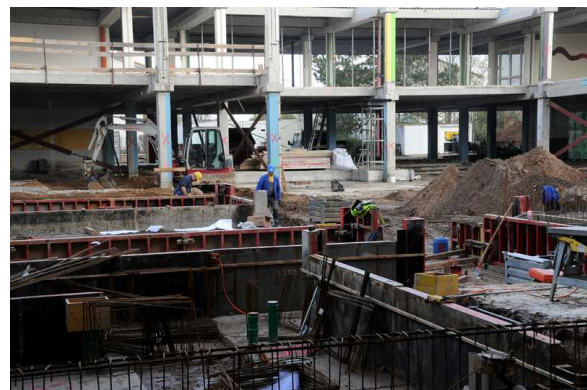
Wiederaufbau - neue Fundamente im Mittelteil der Schule
